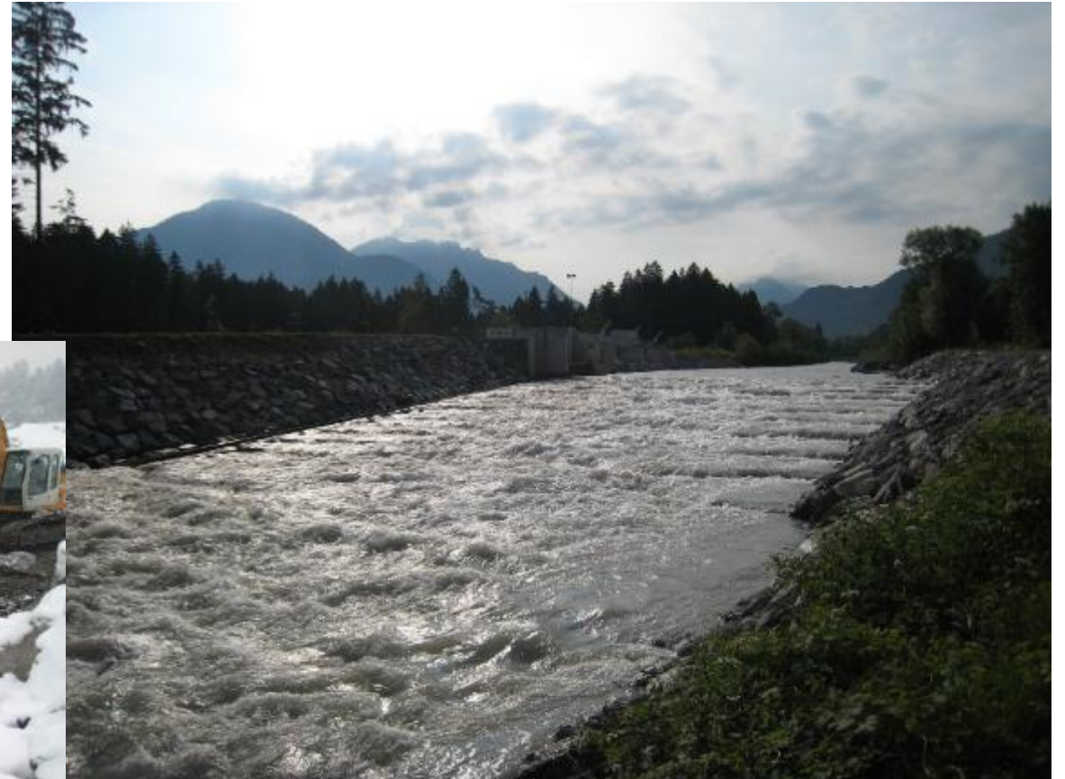
fertige aufgelöste Rampe
