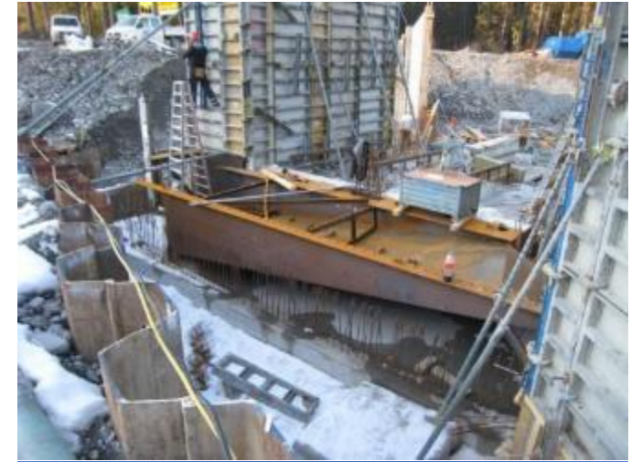
Einlauf KW + Geschiebespüleinrichtung
