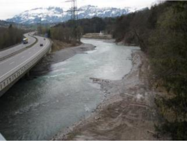
III Gerinneaufweitung, Einbau Bühnen
