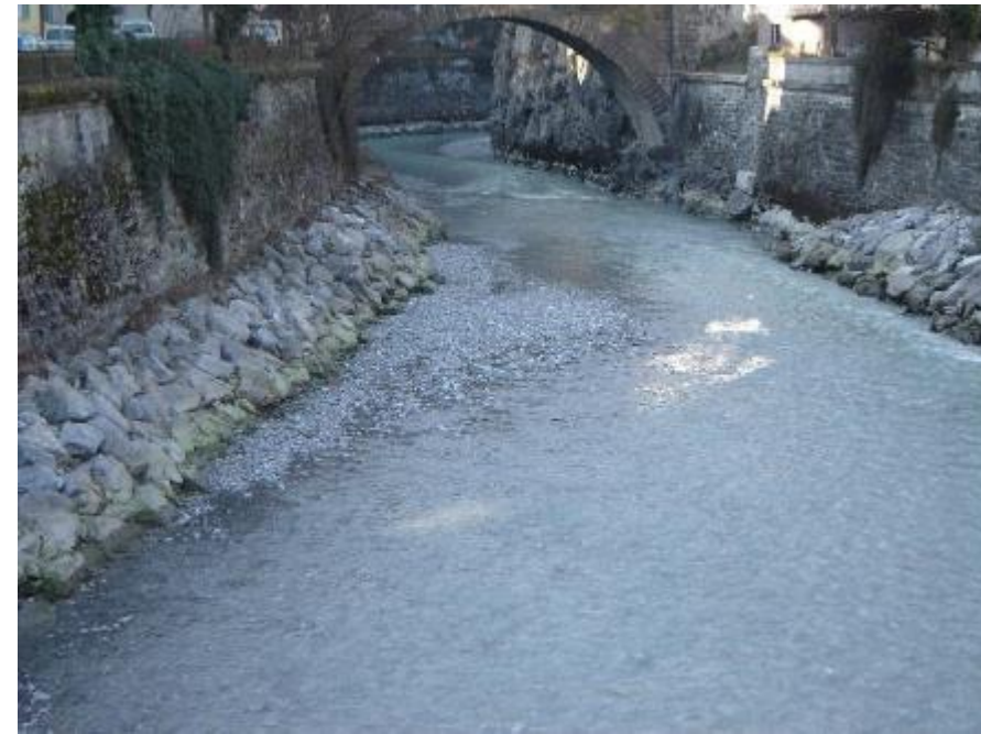
fertiggestellte Sohleintiefung mit neuen Vorgrundsicherung
