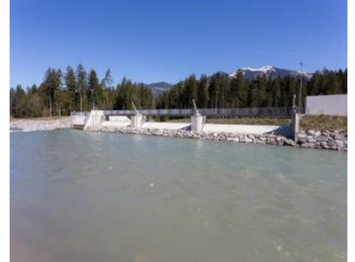
Einlaufbauwerk RHB fertiggestellt
