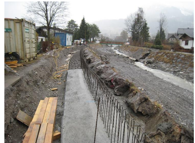
Samina Erhöhung Ufermauern
