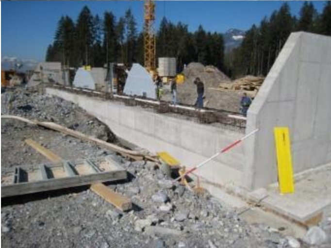
Einlaufbauwerk RHB in Bau
