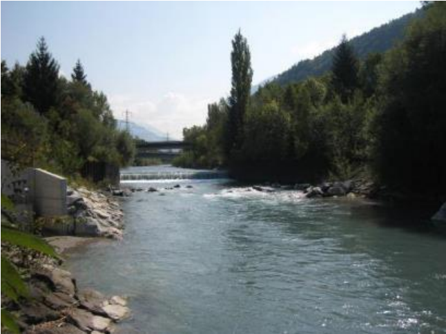
ehemaliger Sohlabsturz Rampe 2
