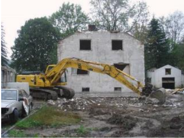
Ablöse u. Abriss von 17 Gebäude
