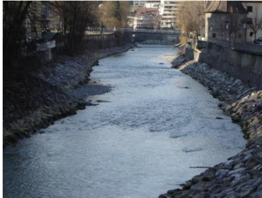
fertiggestellte Sohleintiefung mit neuen Vorgrundsicherung
