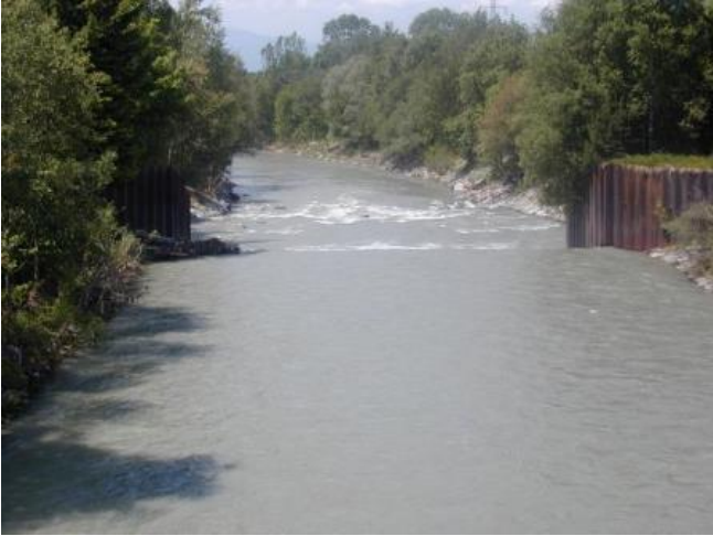
ehemaliger Sohlabsturz Rampe 1
