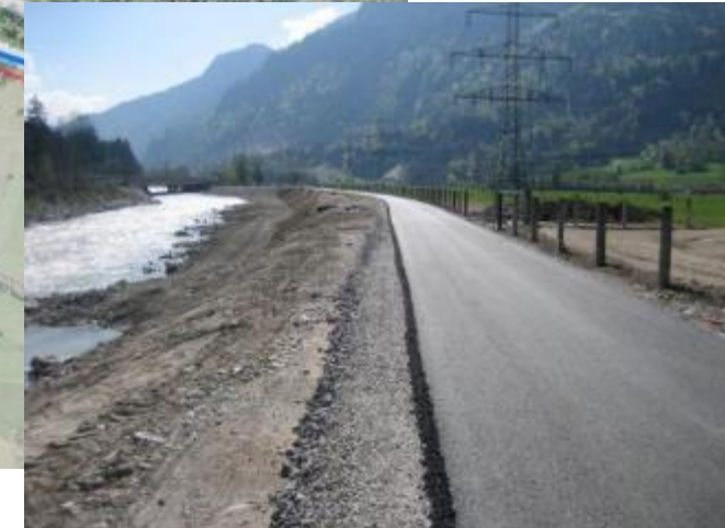
abgeflachte Uferböschung rückversetzter HW-Damm
