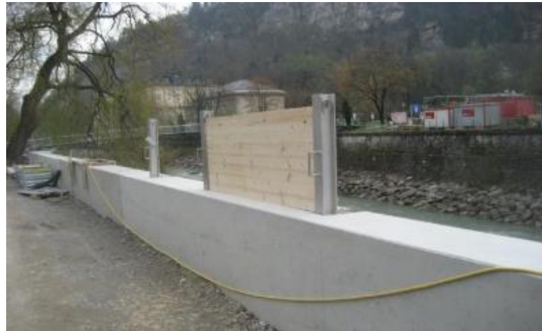
Erhöhung Ufermauern mit mobilen Elementen
