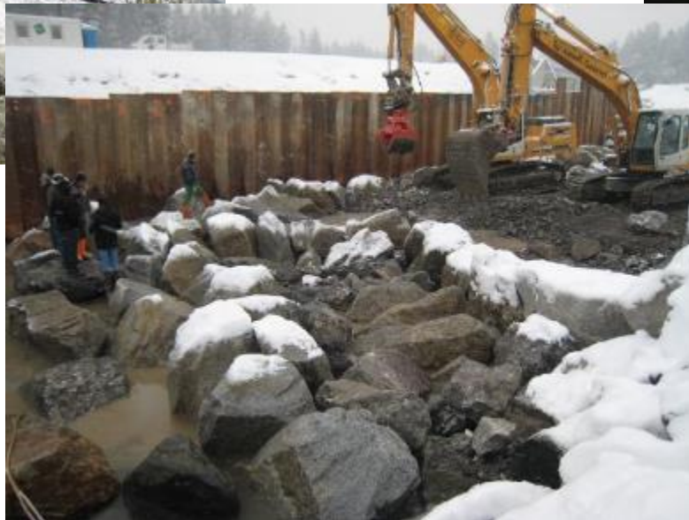
Rampenbau mit Wasserhaltung
