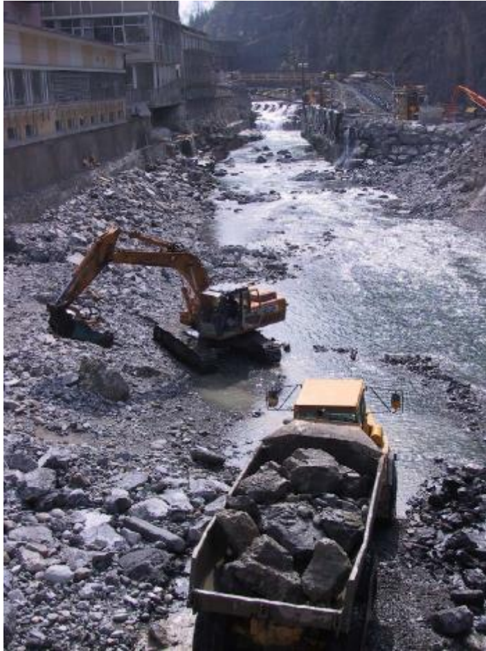
Bau Sohleintiefung rd. 1m
