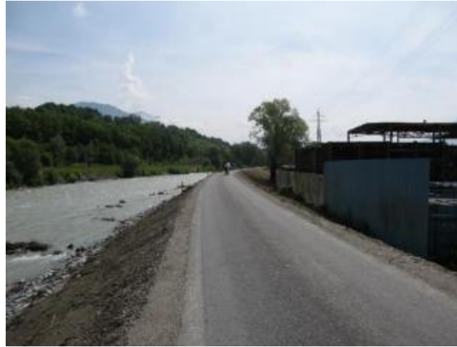
III Sanierung HW-Damm 1 m FB
