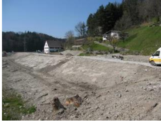
HW-Damm verbleibende Gebäude
