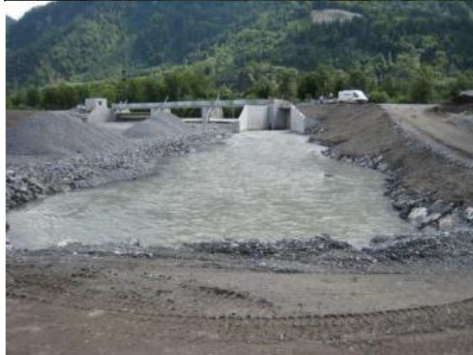
Einlaufbauwerk RHB Einlauf KW
