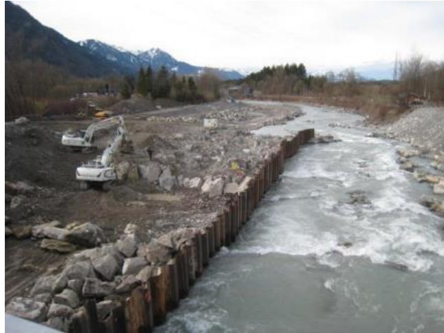
Bau Rampe mit Wasserhaltung
